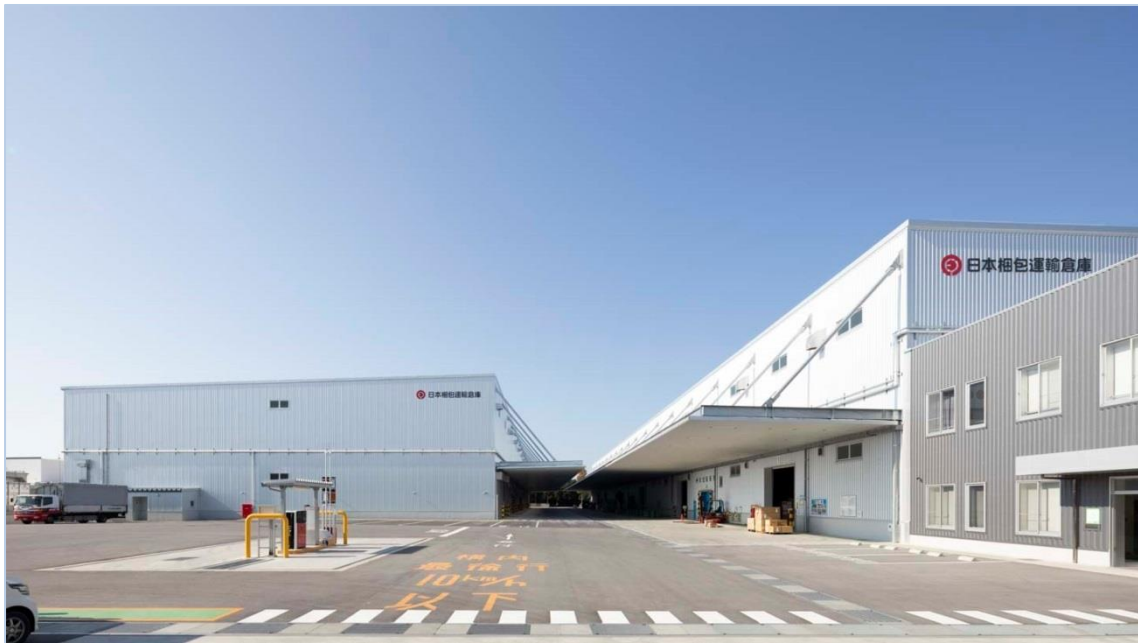
倉庫外観(遠景) (左)今回竣工の第二倉庫 (右)既存の第一倉庫
