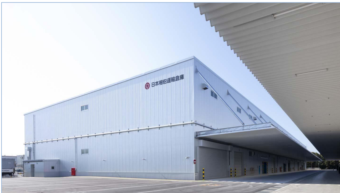
第二倉庫外観(近景)
